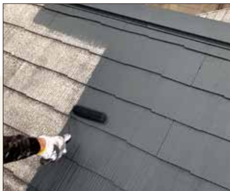
スーパープロガードルーフTPを塗布します
