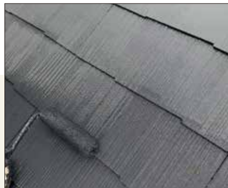
仕上げにもう一度 スーパープロガードルーフTPを塗布します
