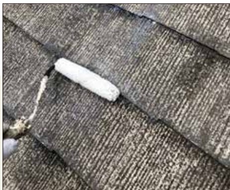
ワイヤーブラシ等で汚れを掻き落とした後、 ストロングプライマーTUを塗布します
